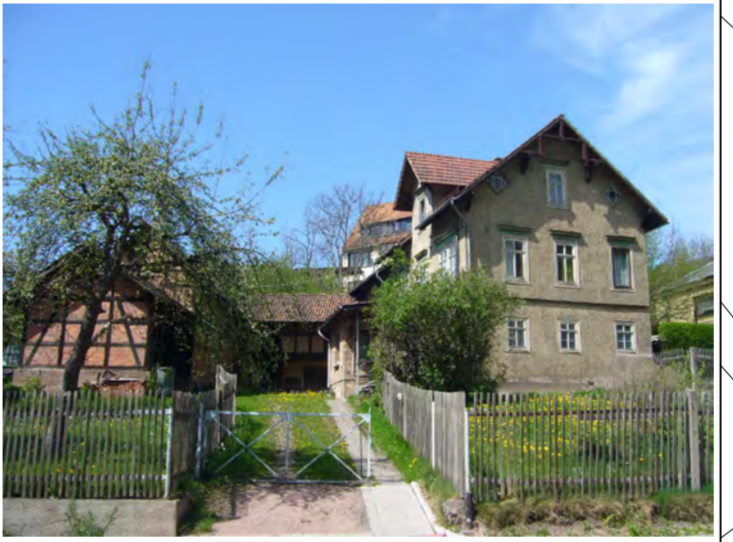
ortsbildprägend ist die einzige Hofanlage des Ortes obwohl sich diese in einem schlechten Bauzustand befindet
