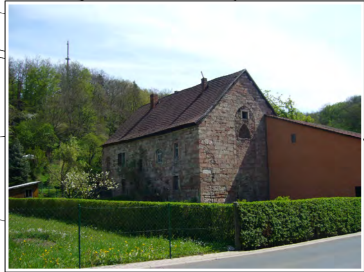
das ehemalige Kloster - denkmalgeschützte Bausubstanz
